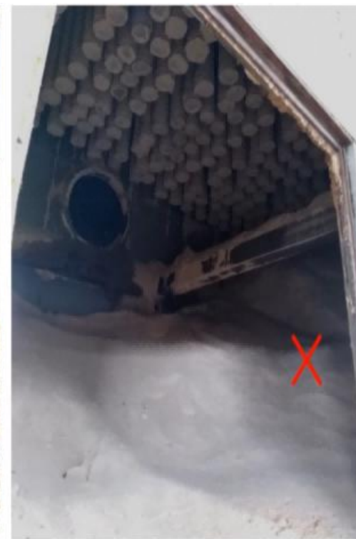
木质粉尘干式除尘系统未设置锁气卸灰装置
