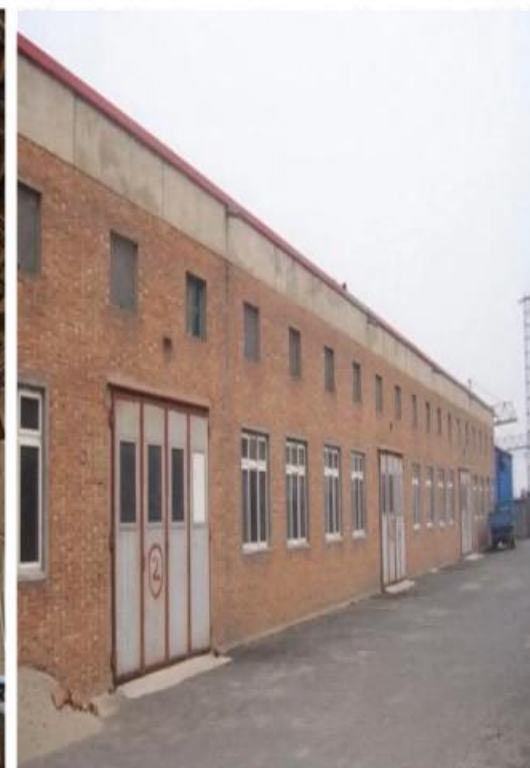
单层砖混结构
