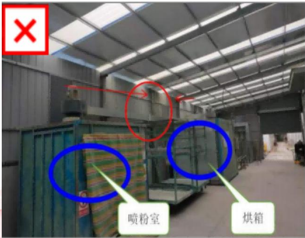
可燃粉尘与可燃气体混用一套除尘器系统
